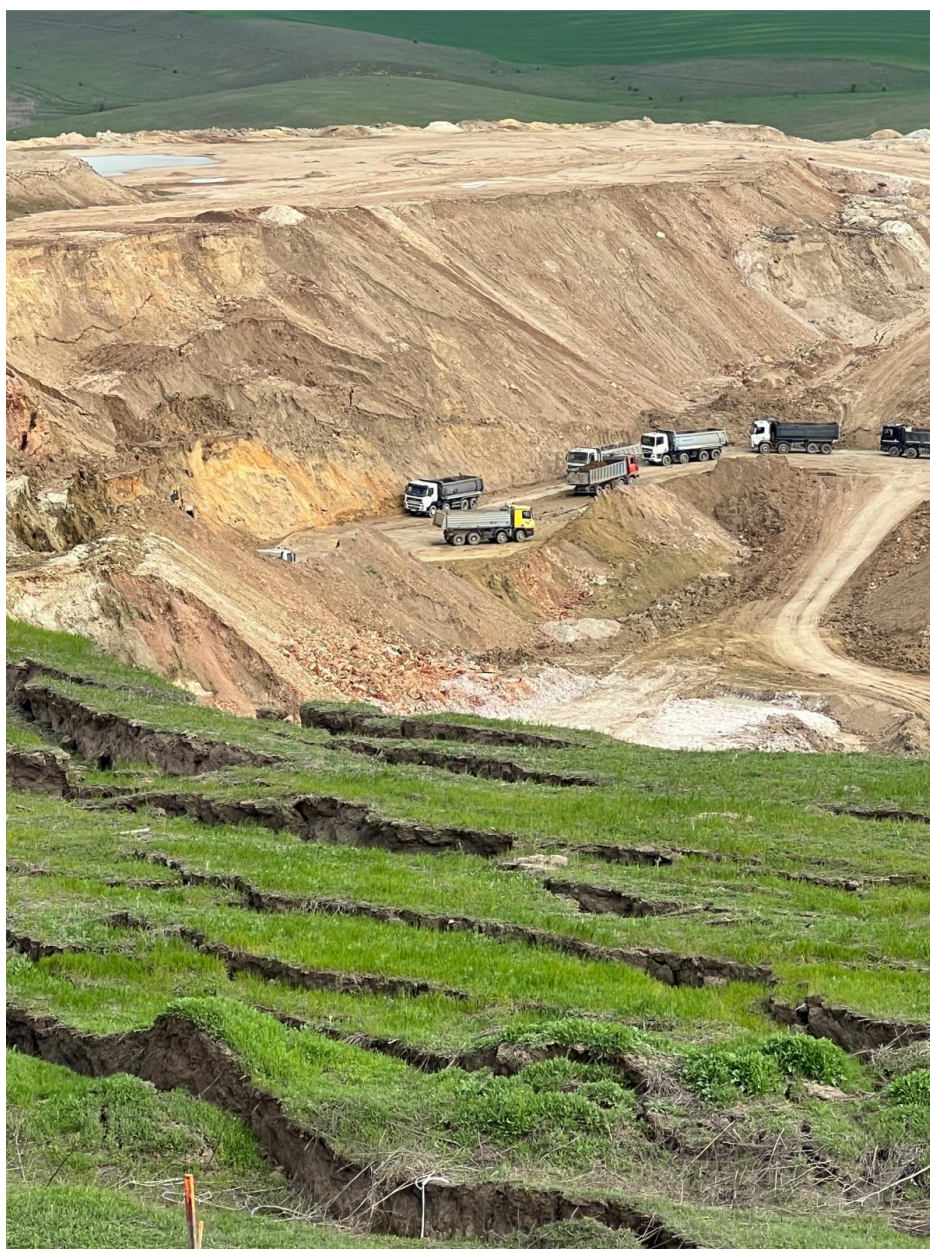
Fig. 5.3: Lucrările continuă în taluz aproape vertical
